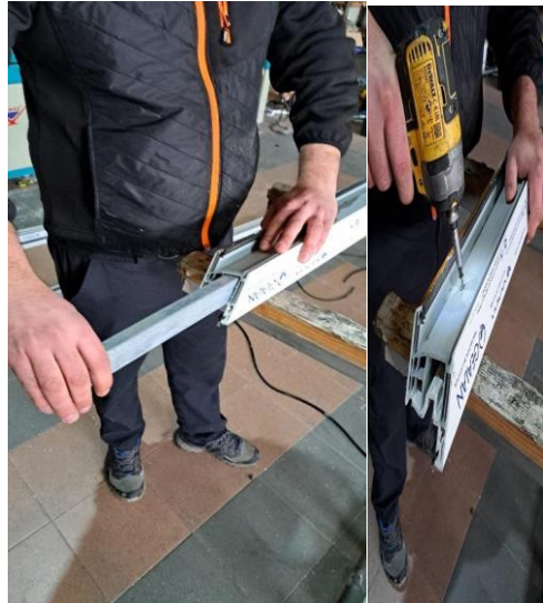
Figura 4.1.2.4. Montimi i përforcimeve të profileve PVC (figura majtas) dhe lidhja e tyre me profilin PVC (figura djathtas)
